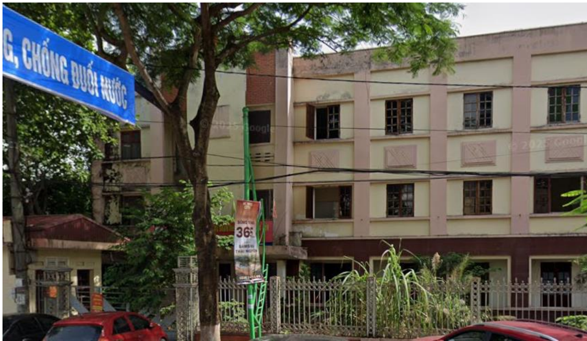
Công trình hiện trạng
